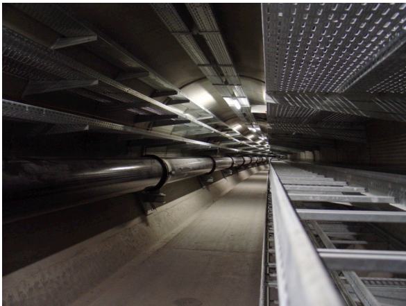
Werkleitungsstollen des Reussporttunnels
