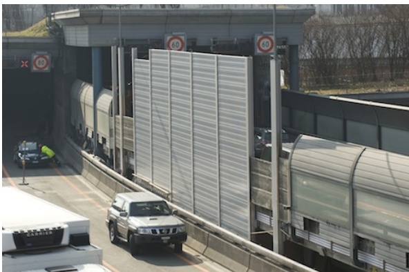
Trennwand am Tunneleingang verhindert, dass Rauch in die andere Tunnelröhre gelangt
