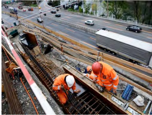
Bewehrung / Schalung Stützmauer Süd
