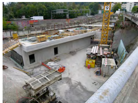
Neubau der Zentrale Lochhof
