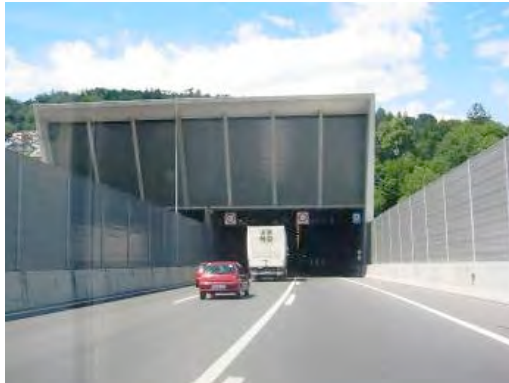
Portalbereich Süd, Grosshof
