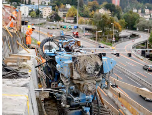
Einbau permanenter Anker
