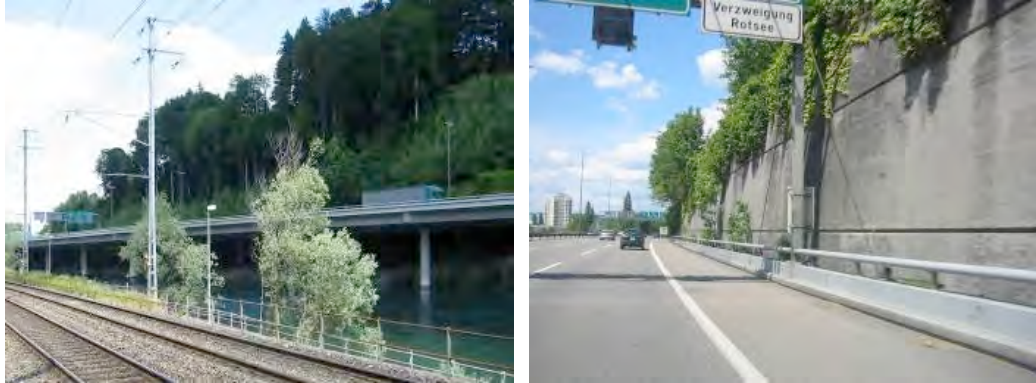
Fahrbahn mit seitlicher Stützmauer
