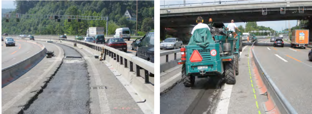
Mittelstreifen befahrbar gemacht
