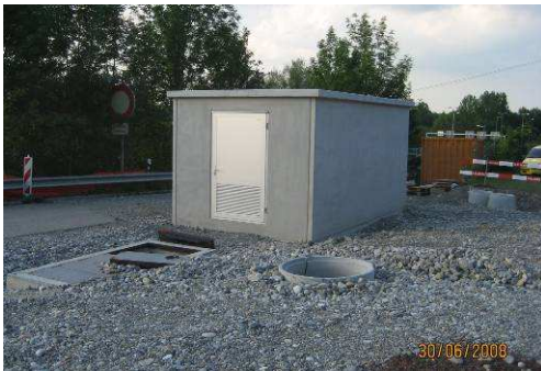
Abb. 4: Neuer Elektrostützpunkt, ESP, notwendig im Hinblick auf die Gesamt-erneuerung Cityring Luzern.
