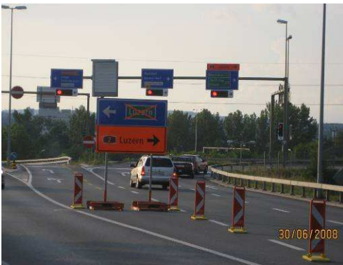
Abb. 2: Umleitung Verkehr über Rampe Grüeblichschachen zur Reduktion der Verkehrsmenge im Baustellenbereich
