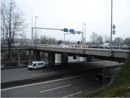
Abb. 1: Ansicht Ibachbrücke über die A2
