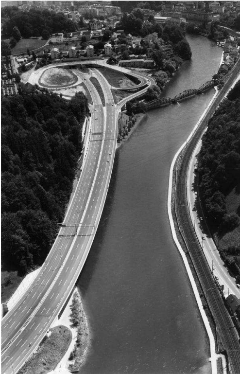
Abb. 1: Gesamtübersicht Lehnenviadukt 1975 [Aufnahme: Archiv Stadt Luzern]
