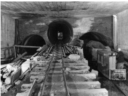
Abb. 2: Ansicht der Tunnelbrüst beim bergmännischer Anschlag Seite Lochhof, Fotoaufnahme aus de 70er Jahren [Aufnahme: Archiv Stadt Luzern]
