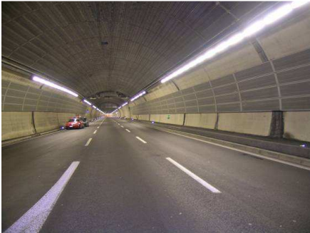
Abb. 1: Innenaufnahme der Tunnelröhre Fahrtrichtung Süden
