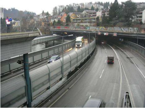
Abb. 1: Lärmschutzwände Projekt «Silentio» Sentibrücke 1 (rechts) und 2 (links), Blickrichtung Reussporttunnel (im Hintergrund Sentibrücken 3)
