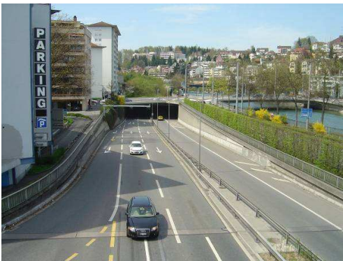
Abb. 2: Stadtanschluss, Ansicht von Süden
