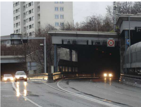
Abb. 2: Einhausung beim Tunnelportal Nord (Lärmschutzprojekt «Silentio»)
