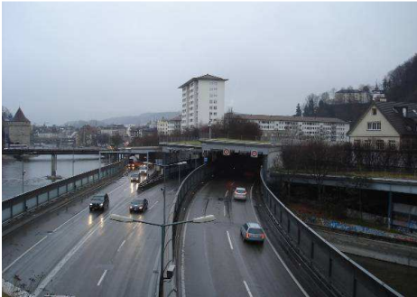
Abb. 1: Sentibrücken, Stadtanschluss und Nordportal Sonnenbergtunnel
