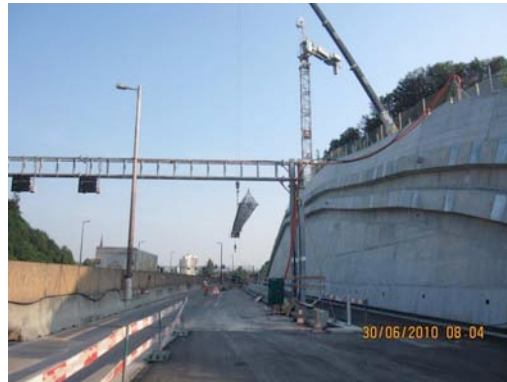
Stützmauern Reussegg–Lochhof zurückversetzt (ohne Lärmschutzverkleidung)
