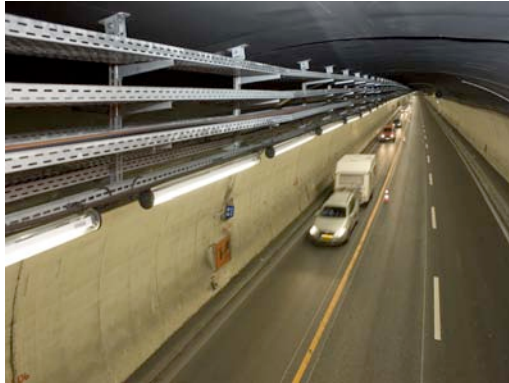
Provisorisches Kabeltrasse
